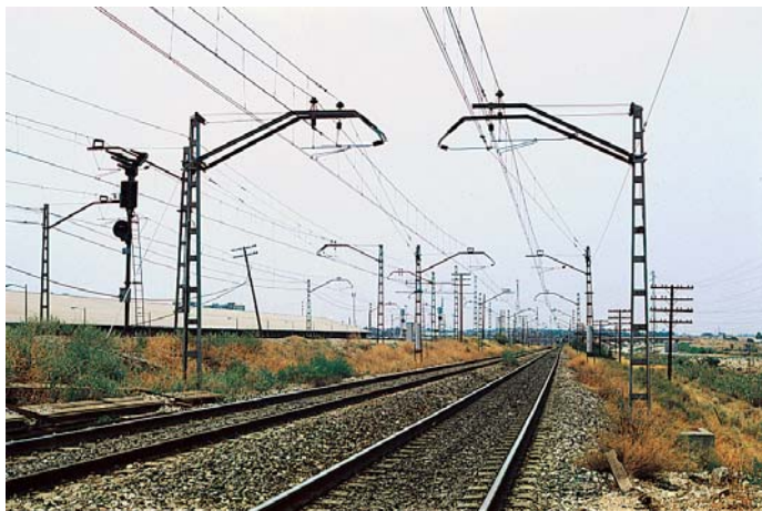
Electrificación de instalaciones ferroviarias en las proximidades de Zaragoza (Foto: Luis Serrano)
