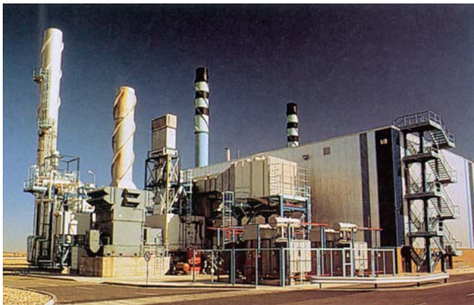
Central de cogeneración asociada a la planta de Opel España en Figueruelas (Foto: DGA)
