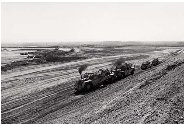
Trabajos de preparación del terreno donde se iba a levantar la planta de General Motors
