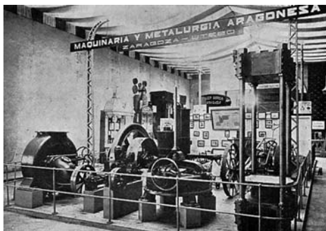
Instalación de Maquinaria y Metalurgia Aragonesa, de Utebo, para la Exposición Hispano-Francesa de 1908 (Foto: Archivo Bibliográfico de la CAI)
