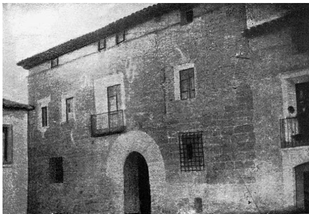
Casa natal de Servet en Villanueva de Sijena antes de su derribo parcial en 1970
