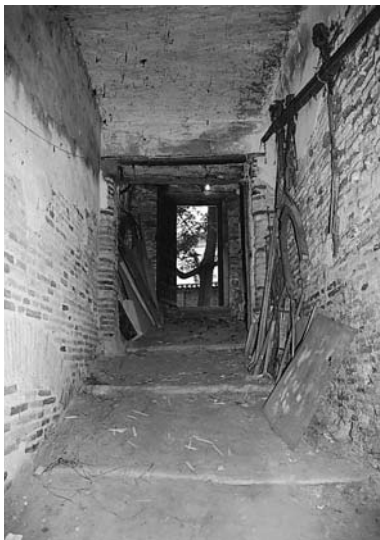
Bajada a las caballerizas en la casa de Miguel Donlope, en la calle Dormer de Zaragoza
