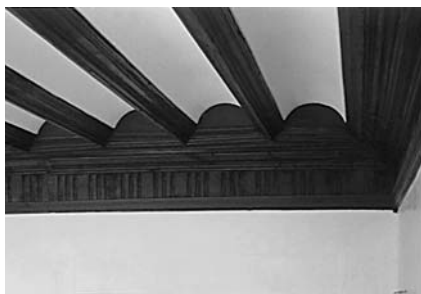
Forjado de bovedillas, en la casa Argensola, de Zaragoza
