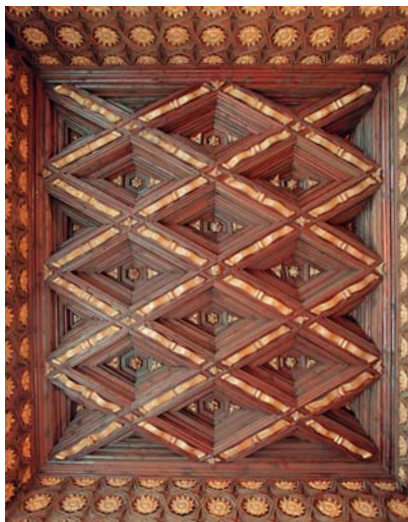
Techumbre de la desaparecida casa de Osera en Zaragoza, cedida por la CAI al Ayuntamiento y hoy instalada en el despacho de la alcaldía
