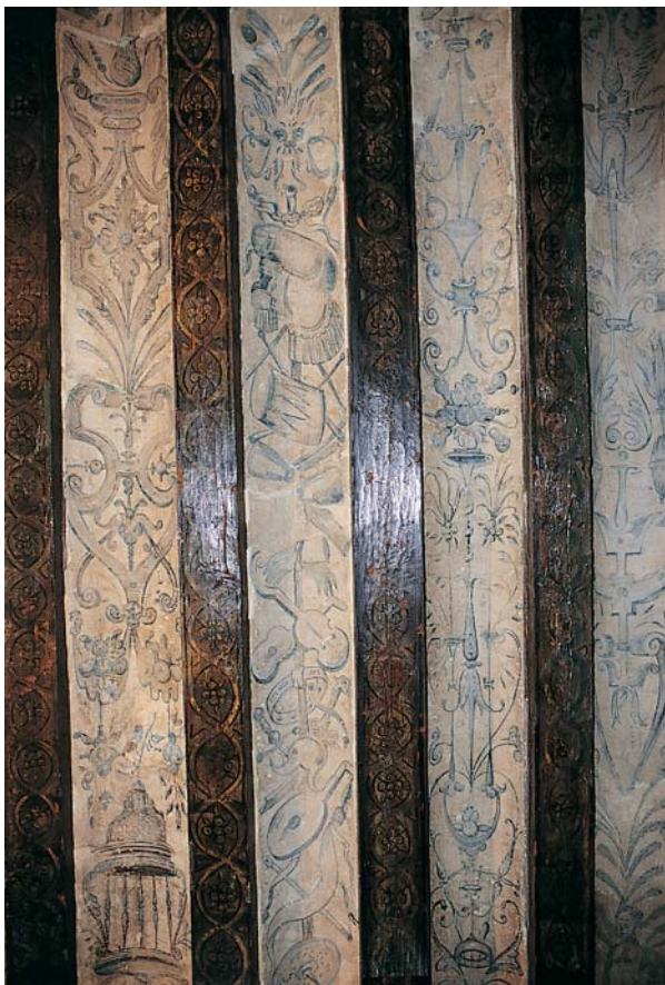
Pintura en el forjado de un "entresuelo" del Palacio de Sástago, en el Coso de Zaragoza
