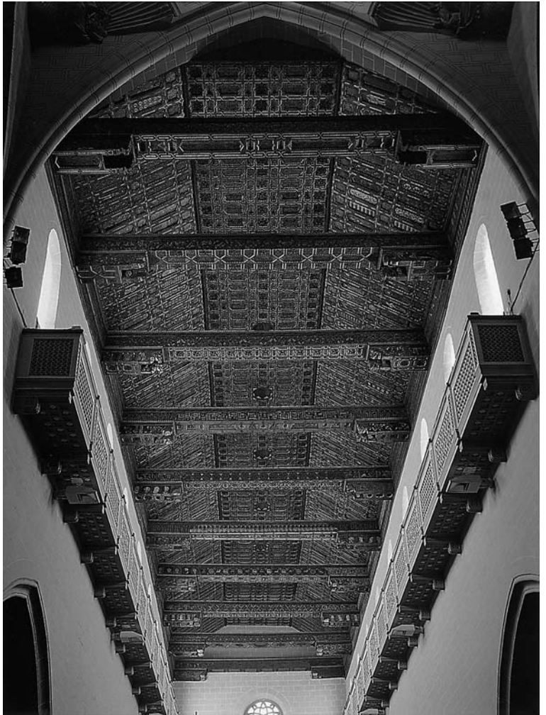
Vista general de la techumbre
