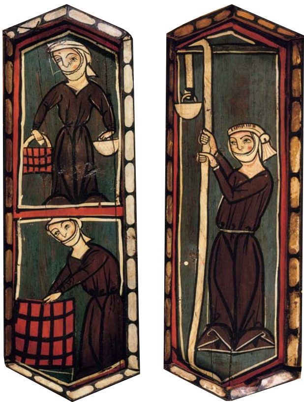
Mujeres con tocado islámico trabajando en obras de construcción, quizá en la propia catedral
