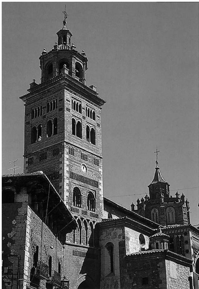
Vista general de la catedral de Teruel, con la torre, naves y cimborrio (Foto: F. J. Sáenz)
