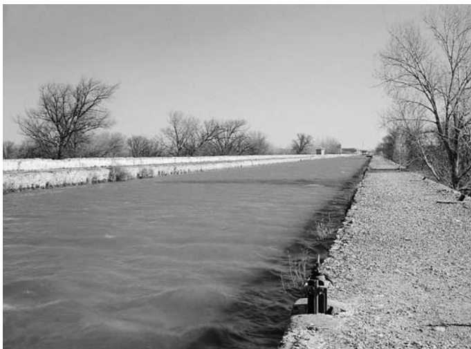
Vista panorámica del Canal Imperial a su paso por el acueducto del Jalón
