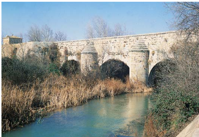
Vista del puente-acueducto sobre el río Jalón
