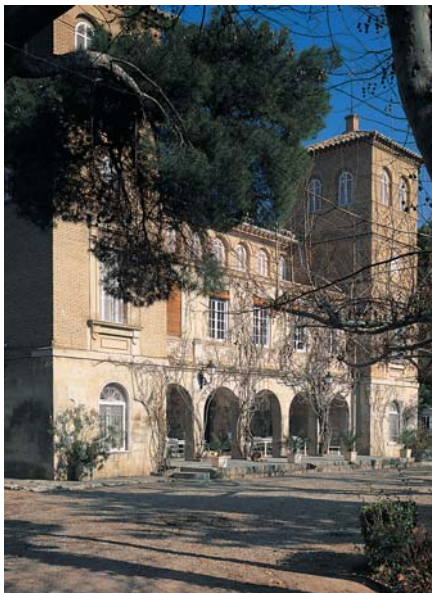
Vista de la fachada del Palacio de Carlos V en El Bocal, junto a Cabanillas
