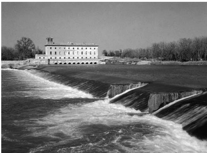
Vista general de la presa y nueva Casa de Compuertas en El Bocal
