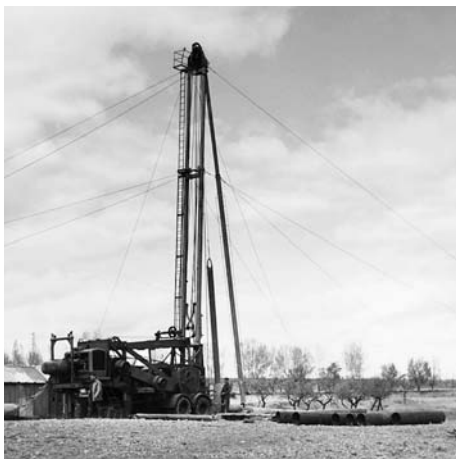
Sondeo en el campo de Cariñena (equipo de perforación del Instituto Nacional de Colonización, año 1964)
