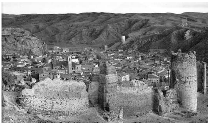
Vista general de Daroca (Foto: M. Grima)
